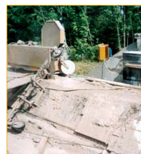
Канатный автомат CSA-1001 H при горизонтальной резке мостовой опоры
