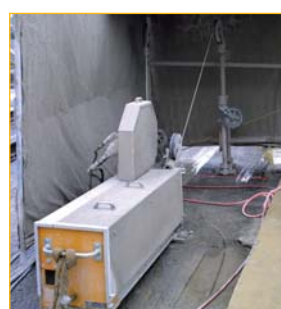
Канатный автомат CSA-1001 H при вертикальной резке боковины моста
