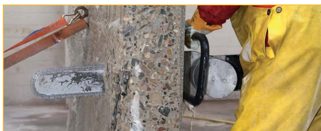
Высокочастотная цепная электропила СКЕ-943 HF F4
